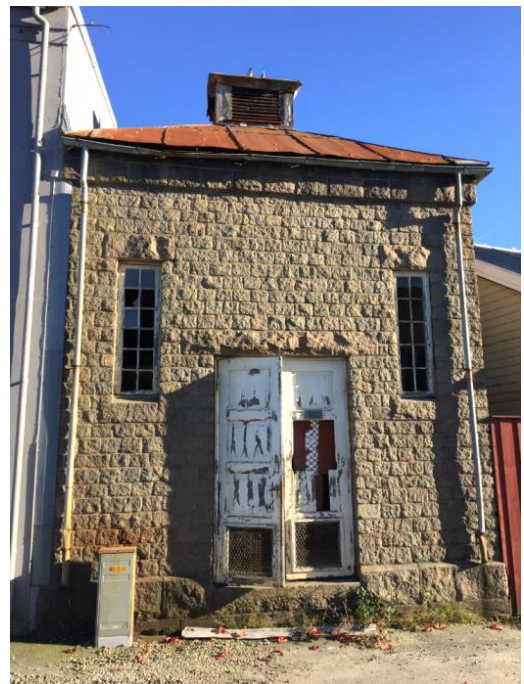
Det er kun trafoen (1914) på Nedre Malmø som har formelt vern
